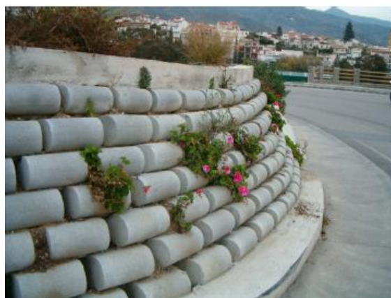
Colocación Cara Curva
